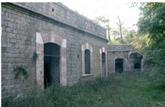
Forte Portuense. Il percorso di accesso alla piazza d'Armi e il fabbricato ufficiali allo stato attuale
